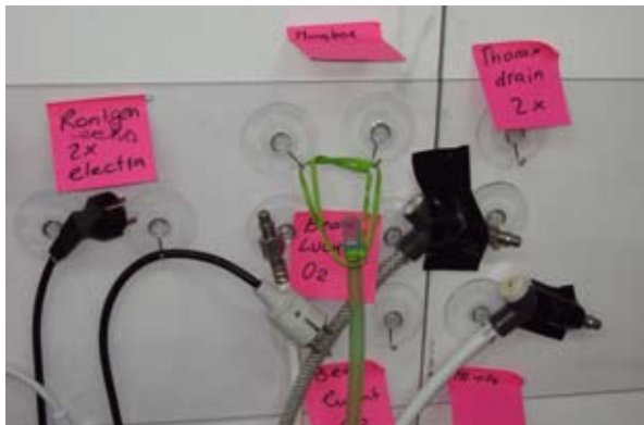
Afbeelding 2. Gewenste posities van aansluitpunten voor apparatuur, de positie van het bed en de couveuse, kijk- en looplijnen werden in overleg met de gebruikers direct gemarkeerd op de mock-up
